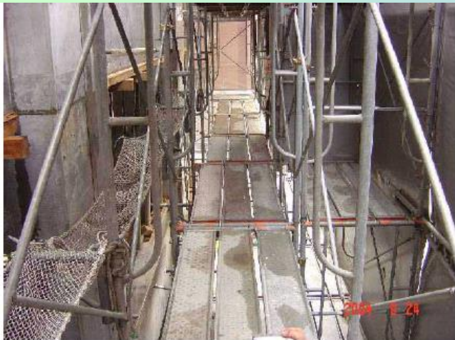
照片 3. 工作台寬度應在 40 公分以上並鋪滿密接之板料(板料間及板料與施工架間之縫隙不得大於 3 公分)。(營造標準第 48 條、國家標準)
