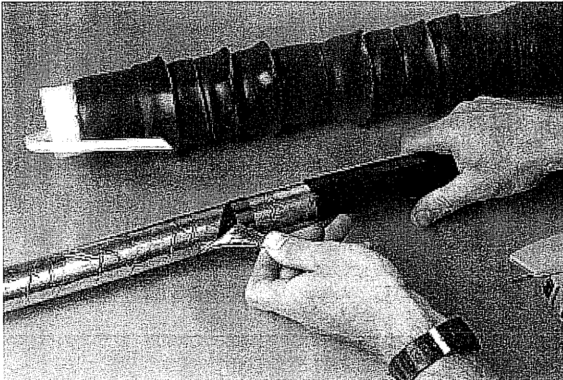
相片 4 利用捲夾 (roll clip) 以切割並移除銅箔屏蔽 (screen)。
