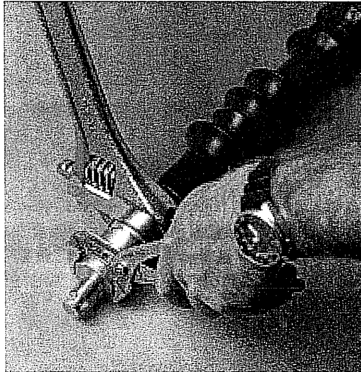
相片 12 以適當之工具確認作成終端之耦合 (termination coupling) 已被鎖緊。
