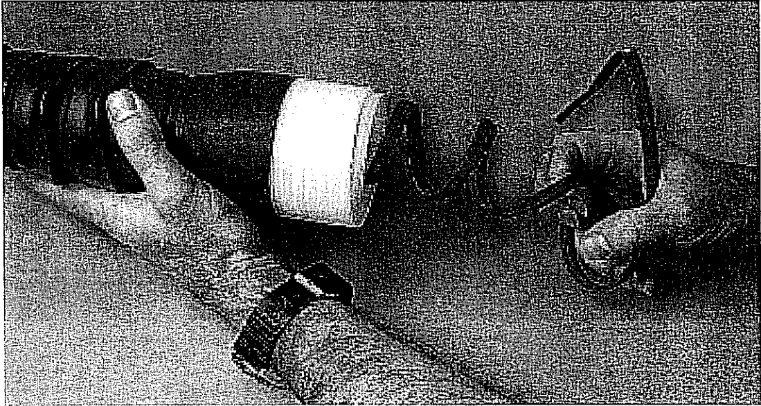
相片 8 在冷縮套被放在 ERICORE 之前，須確定紅色內部螺旋線，已先從冷縮套之內側被移除
