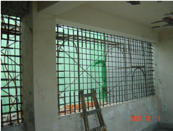
(3) 剪力牆補強
