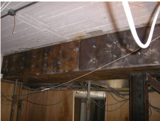
(5A) 鋼板(梁)補強
