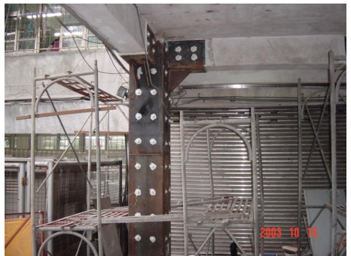
(5B) 鋼板(柱)補強
