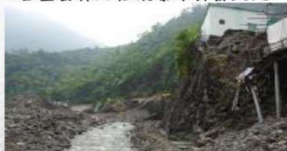
凡納比颱風造成來義鄉道路塌陷
