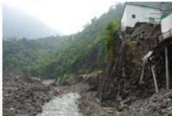
凡納比颱風造成來義鄉道路與民宅下邊坡塌陷
