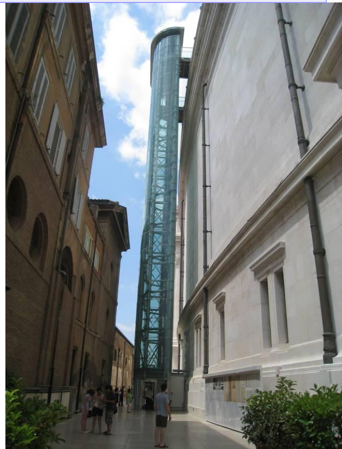
昇降機設置於建築物後面，完全不影響古蹟之外觀
