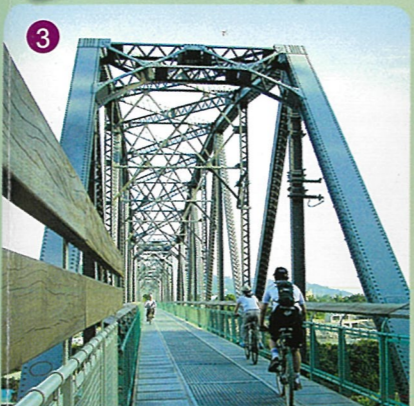
3 舊山線花樑鋼橋 382公尺 建於1908年由朝倉技師負責設計監造，全長382公尺共有六組鋼樑桁架橫跨橋墩，背倚九號隧道南下出口，景色優美壯麗，民國87年因台鐵舊山線鐵路路線切換而走入歷史，台中縣政府突破困難、展開創意，賦予花鋼樑橋新的生命力。
