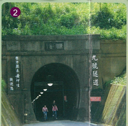
2 九號隧道 於1908年3月31日完工，全長1273公尺是台鐵舊山線最長的一座隧道，隧道北口有《潛行不宣》南口有《氣象雄深》之題字，隧道內裝置照明、通風及監視等設備，讓幽暗濕冷的隧道重建光明，距離北隧道口500公尺有湧泉，目前仍持續湧出。
