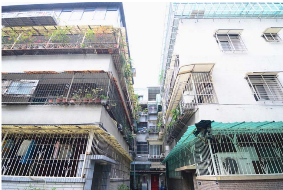
老舊公寓建築物外觀
