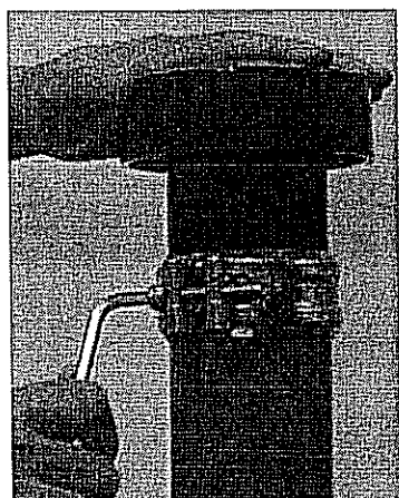
三、用工具上緊壓環接頭至適當緊度，使吸氣閥固定不洩露
