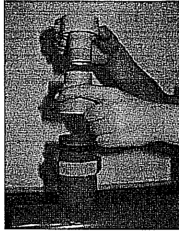
二、將 1" NPT Durgo 吸氣閥與專用接頭栓緊準備與迫緊螺帽銜接
