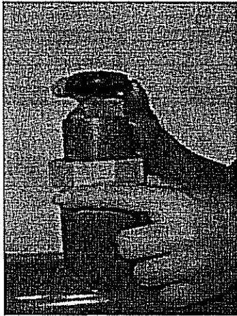
一、將迫緊螺帽及迫緊套入 40A PVC 管外
