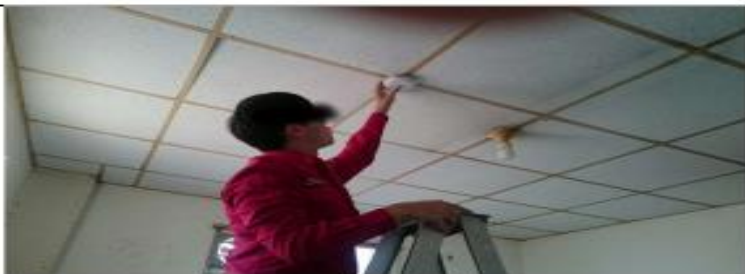
裝設住宅用火災警報器照片
