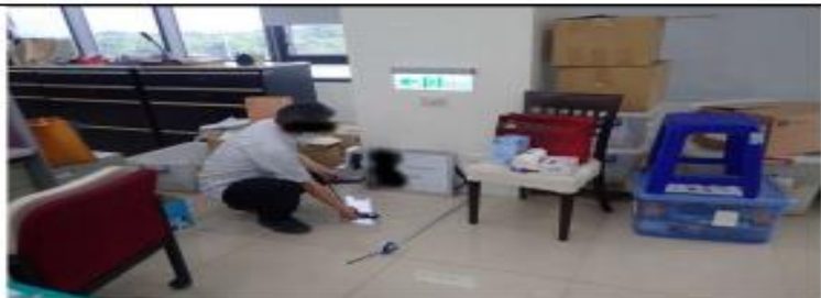
避難方向指示燈移位設置照片
