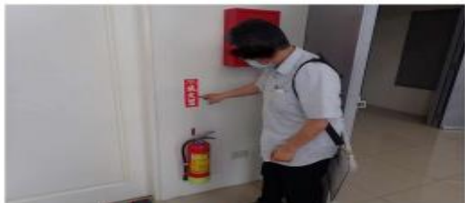
加設滅火器照片
