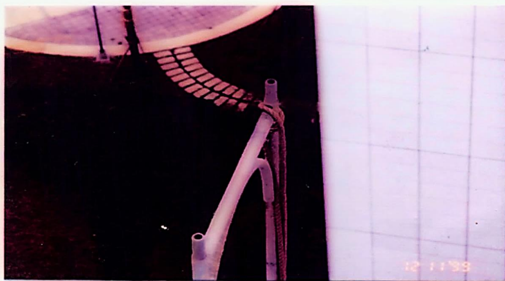
說明：麻繩纏繞於門型框式施工架上。
