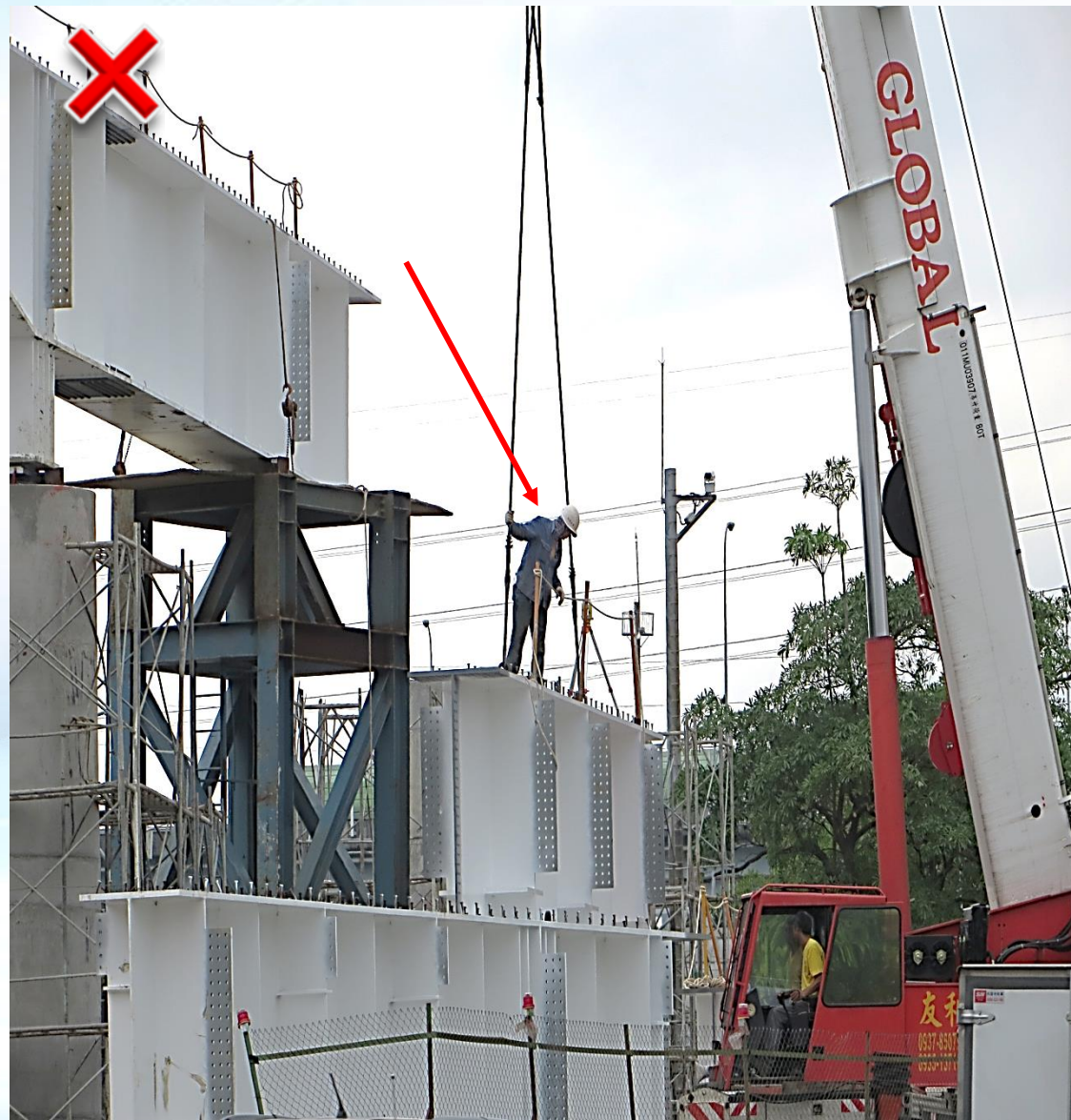
起重吊掛作業，應以吊物為限不得乘載或吊升勞工以防止墜落
