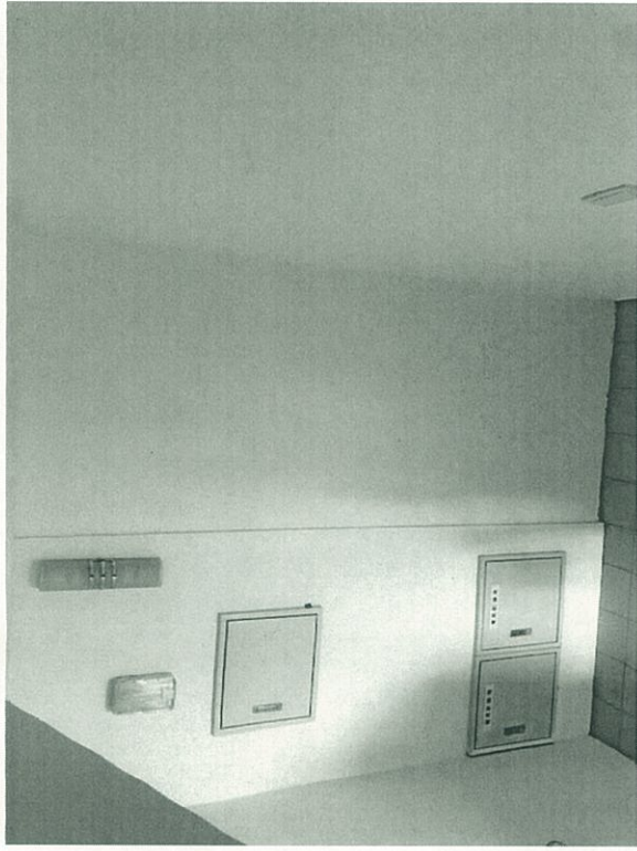
七層夾層增設牆面封閉原水塔空間
