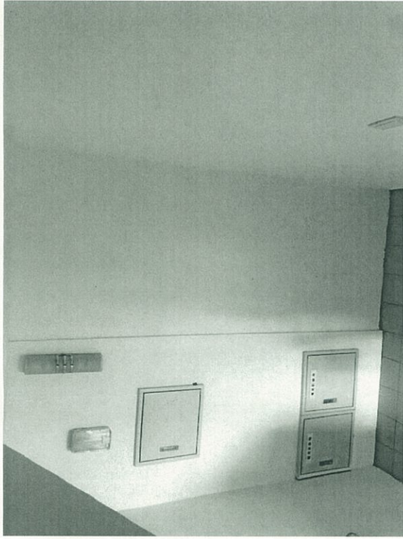
七層夾層增設牆面封閉原水塔空間
