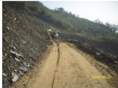
便道路基施工中
