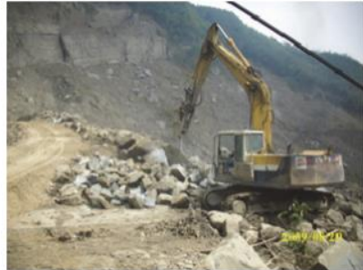
便道路基填塊石就地取材破碎加工中
