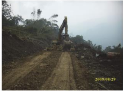
便道路基填塊石施工中
