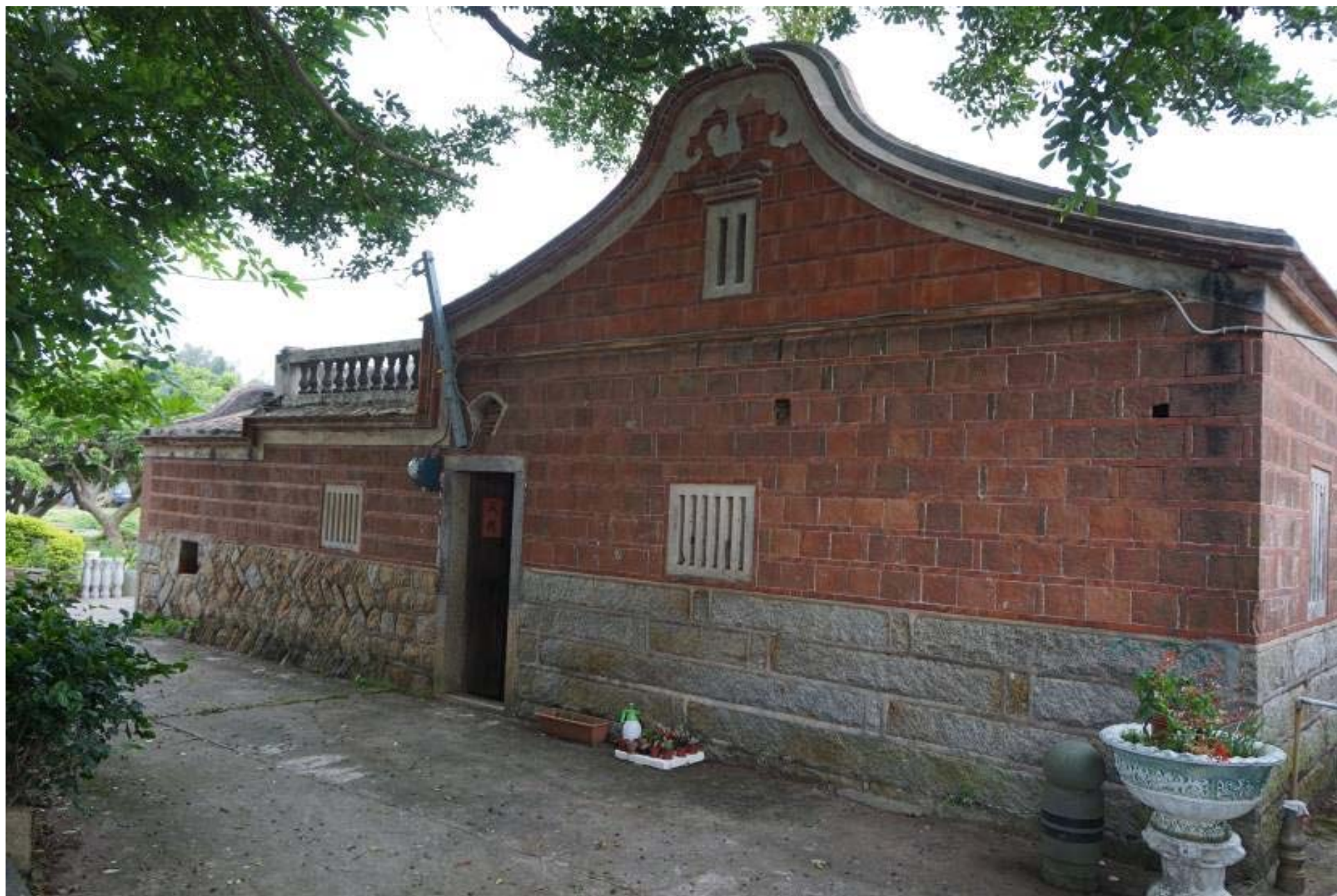
中蘭29號-左側立面修復前
