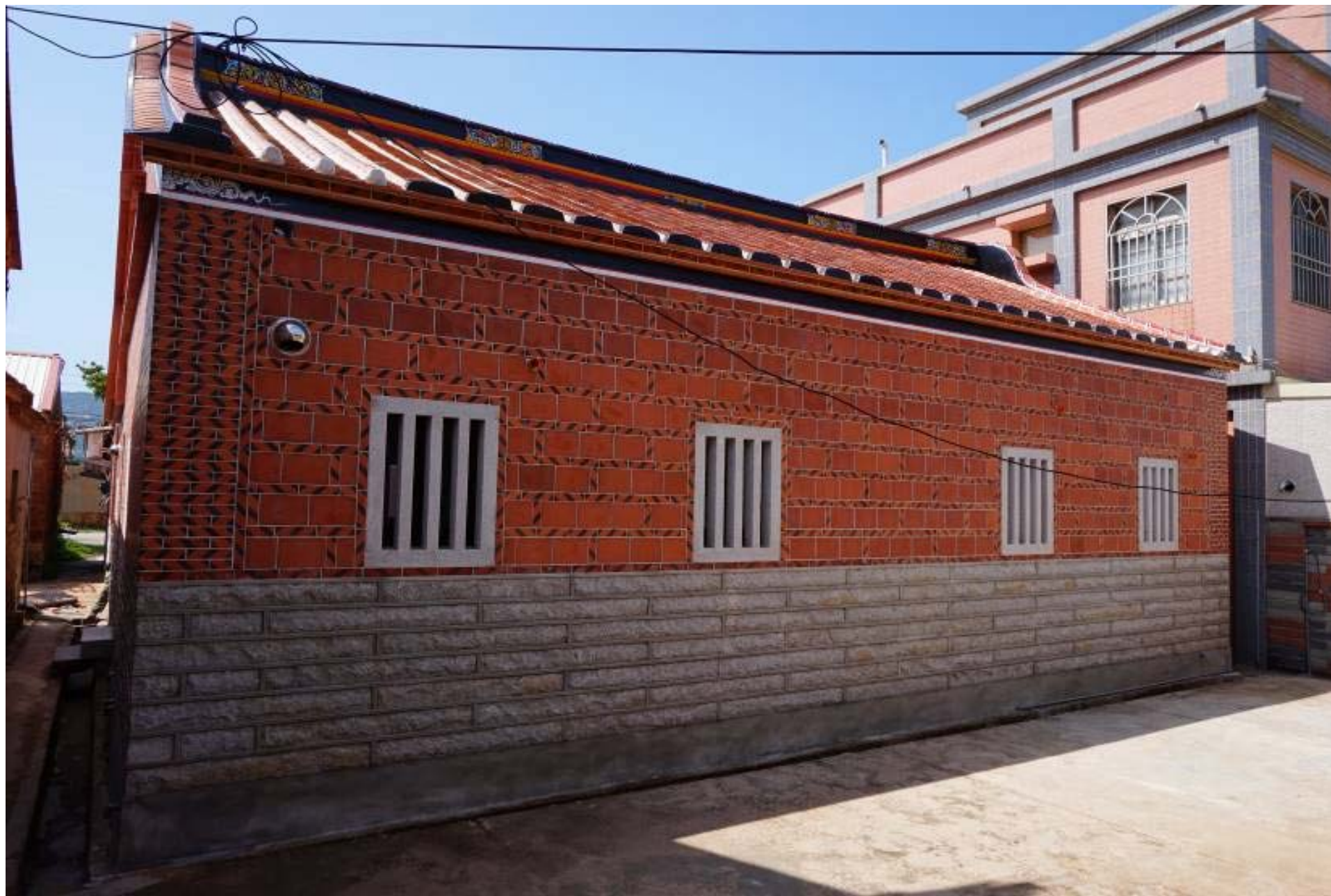
后浦頭60號-背面修復後
