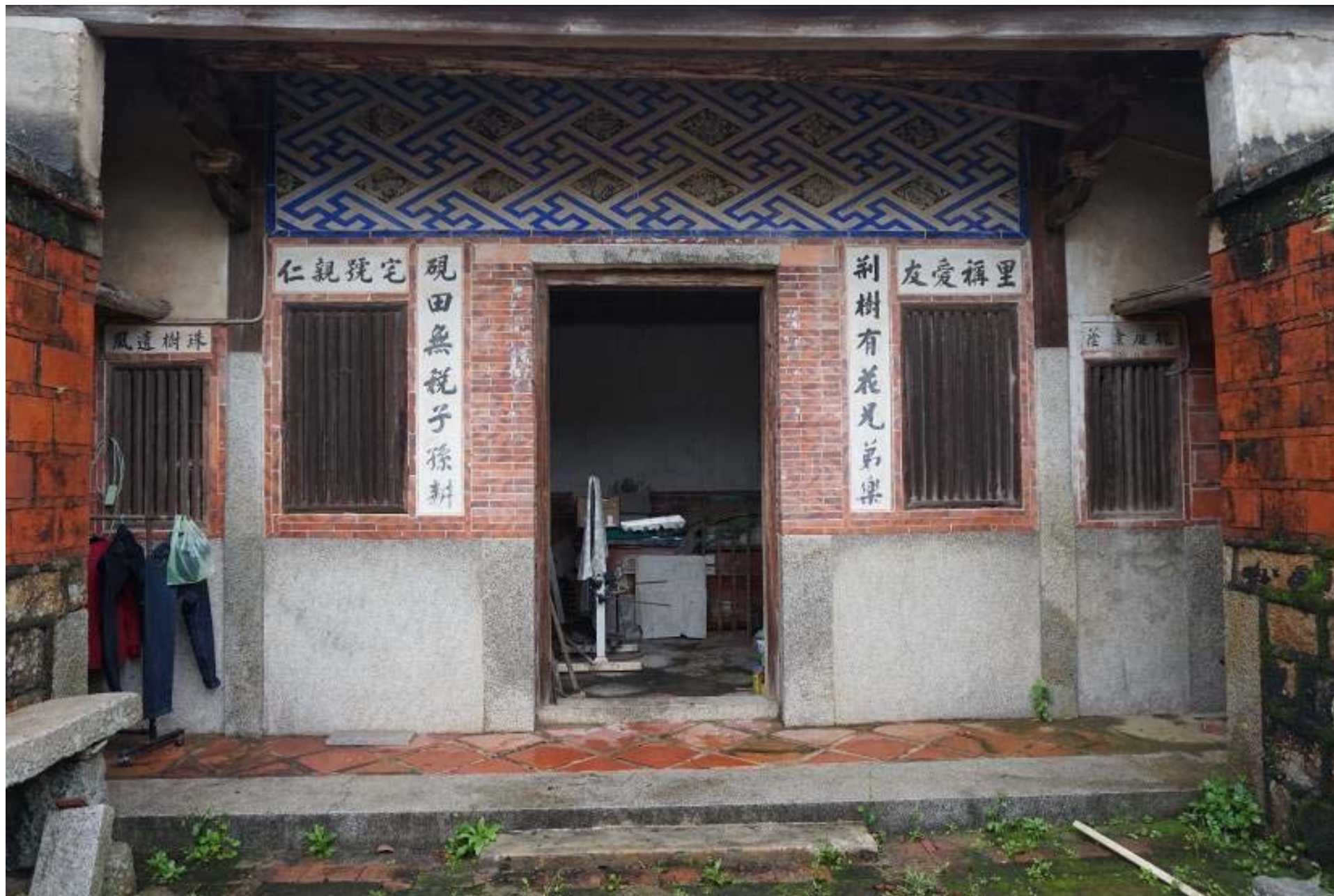
中蘭29號-主廳正立面修復前
