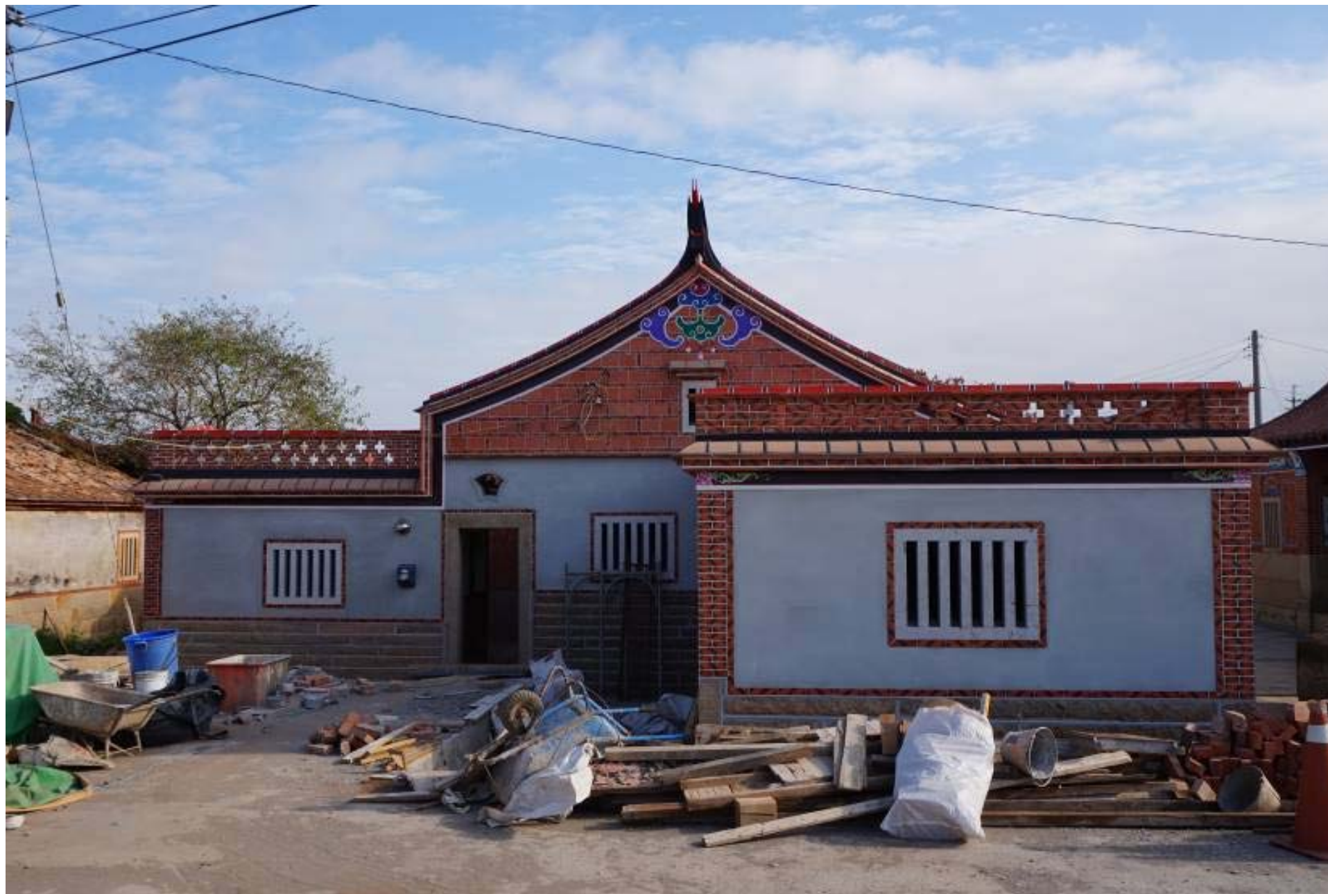
浦邊13號-右側立面修復後
