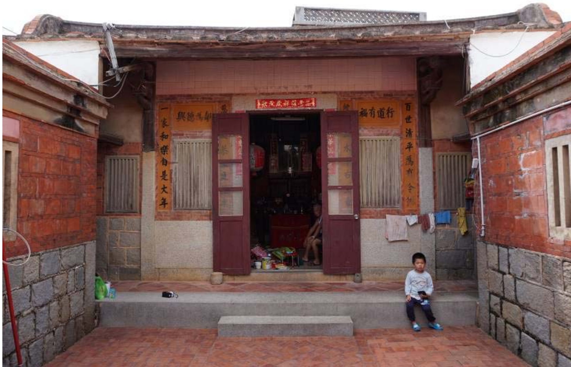
泗湖10號-主廳正立面修復前
