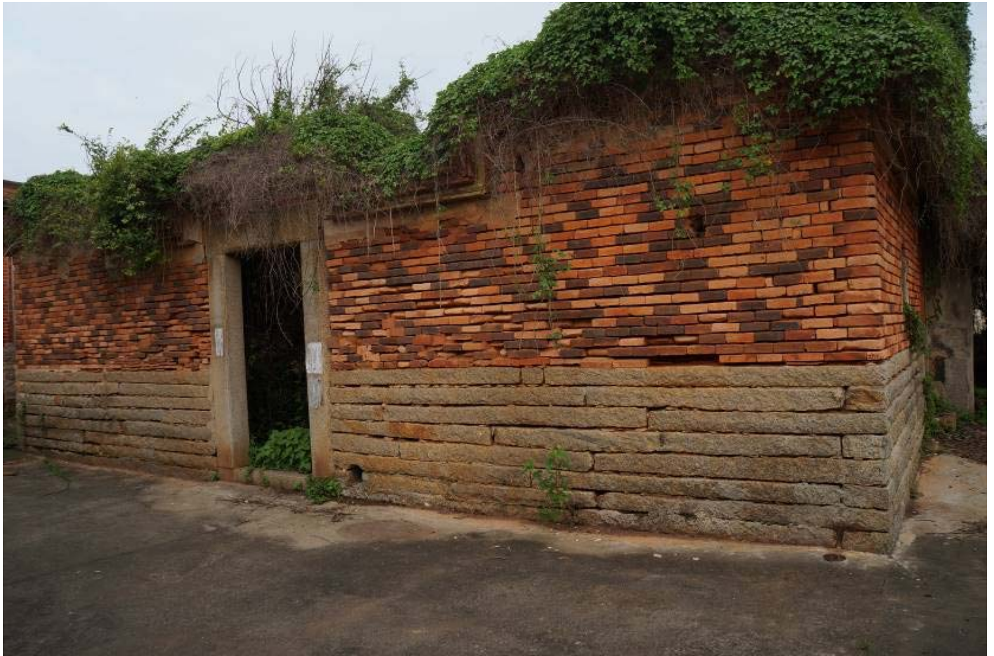
浦邊13號-立面修復前
