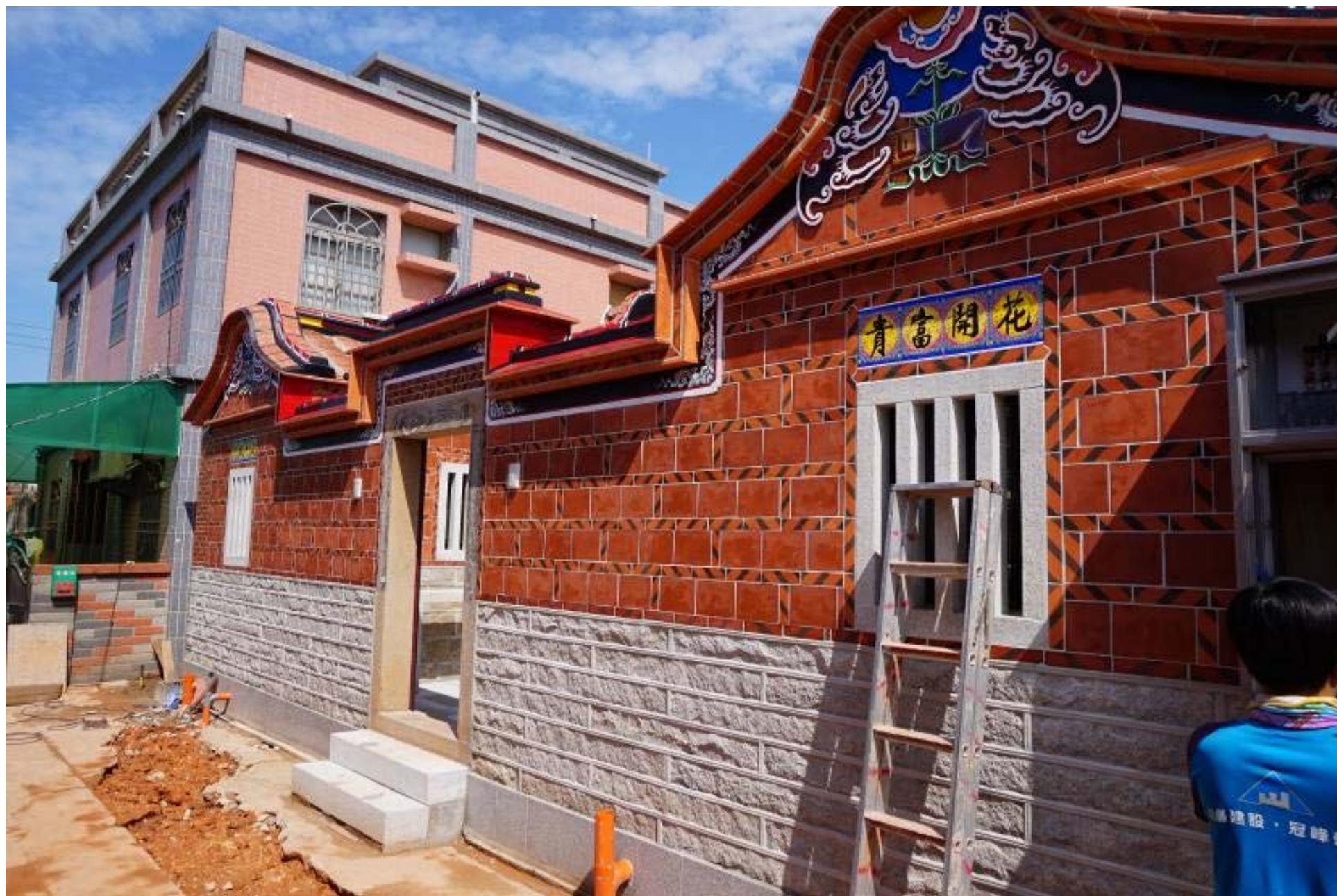
后浦頭60號-立面修復後
