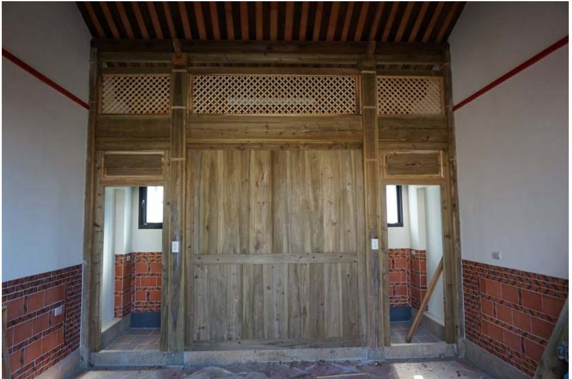
浦邊13號-主廳壽屏修復後
