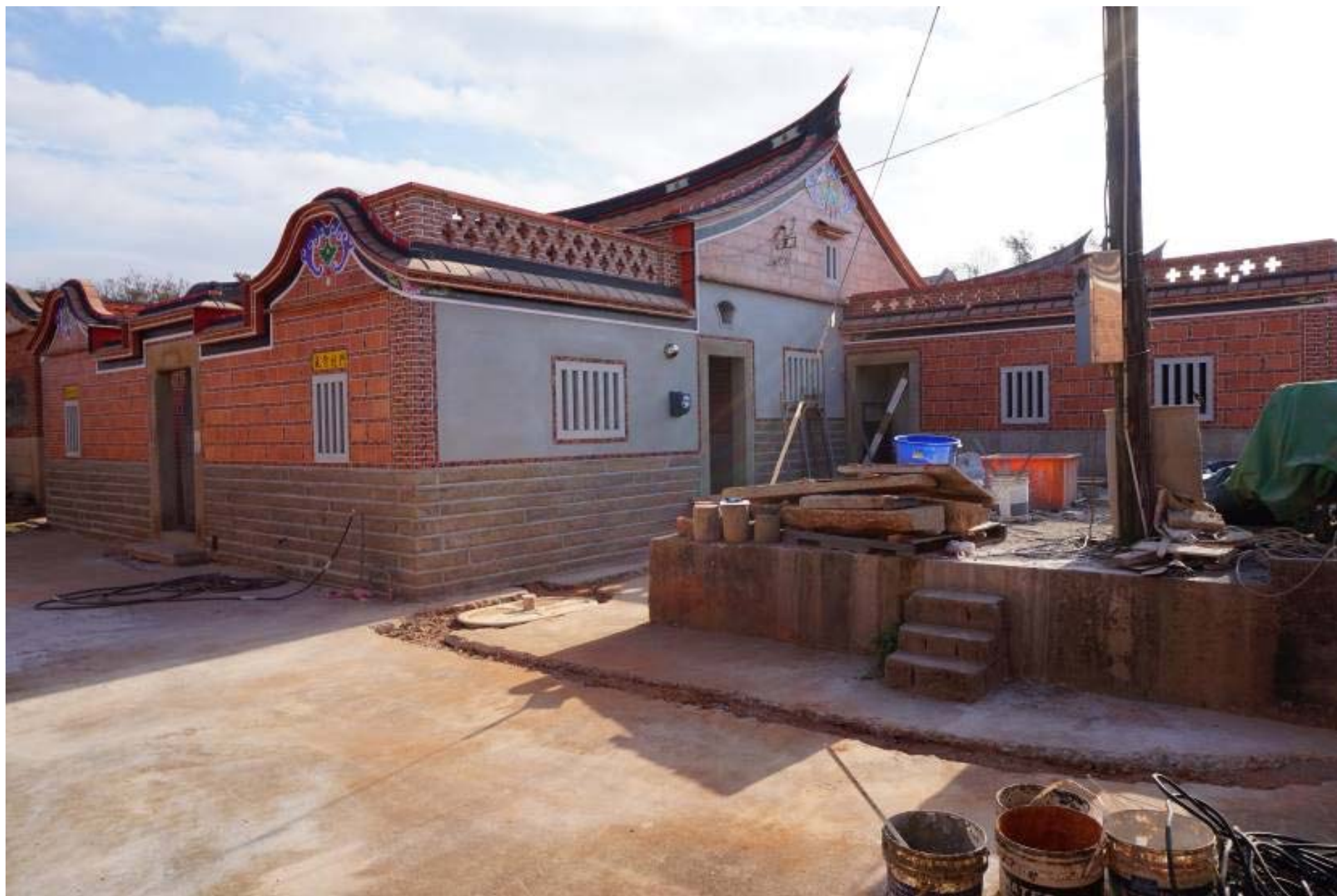
浦邊13號-立面修復後
