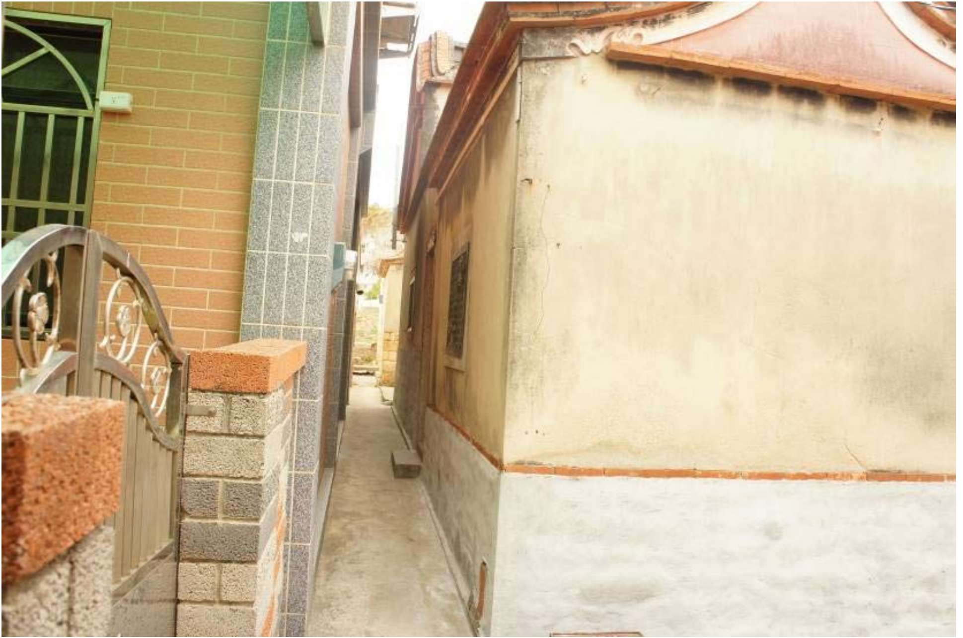
后浦頭60號-右側立面修復前
