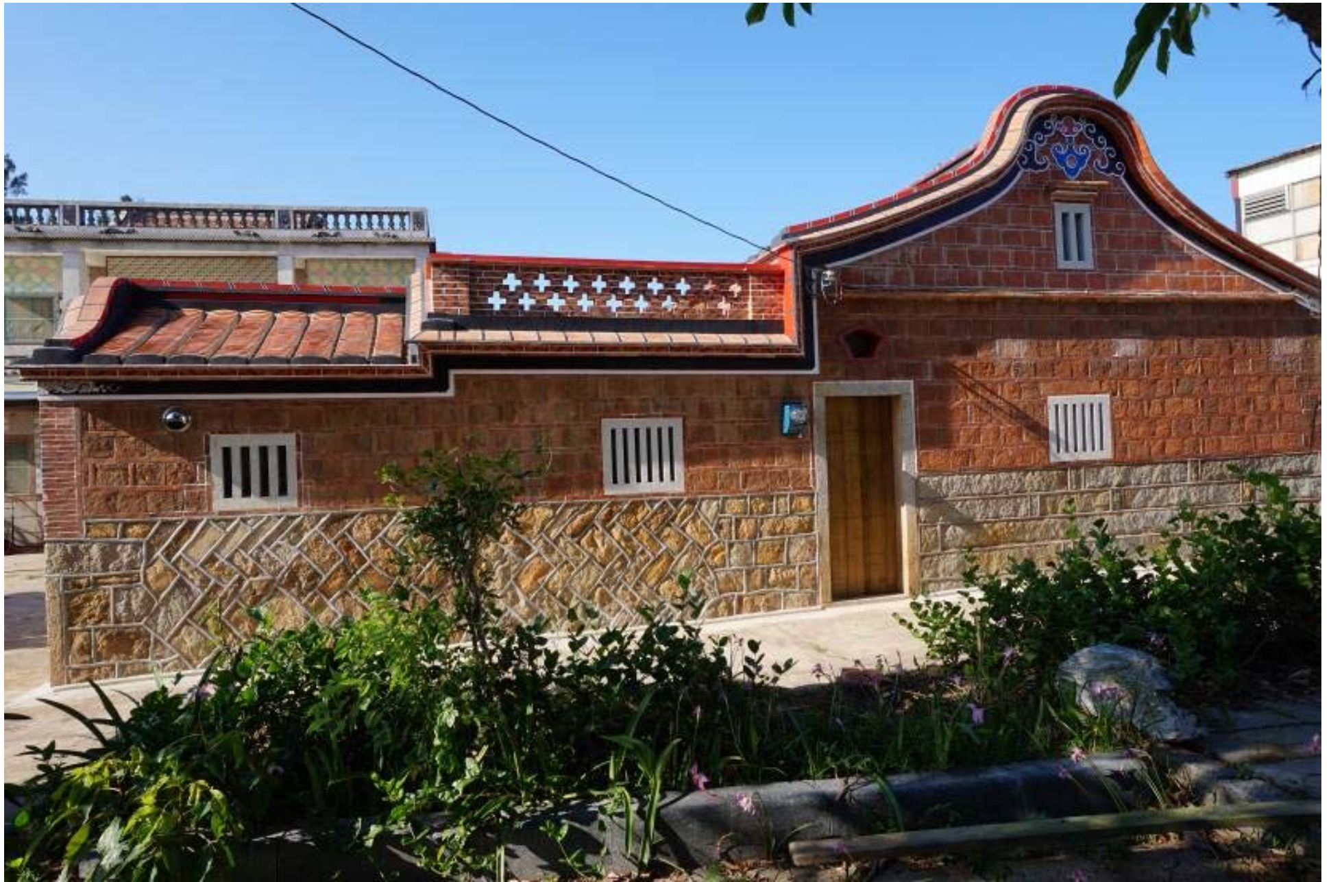
中蘭29號-左側立面修復後
