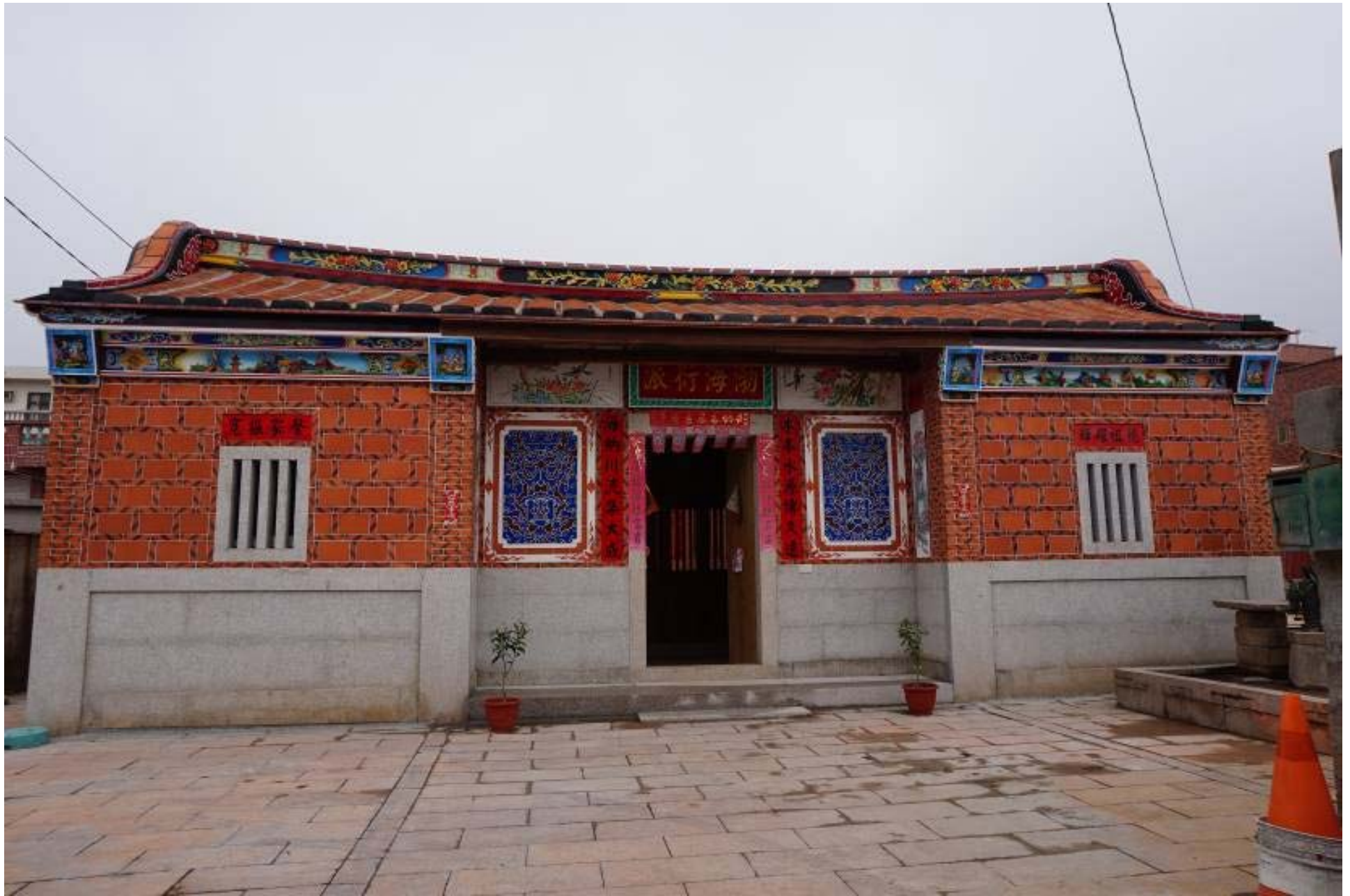
泗湖10號-立面修復後
