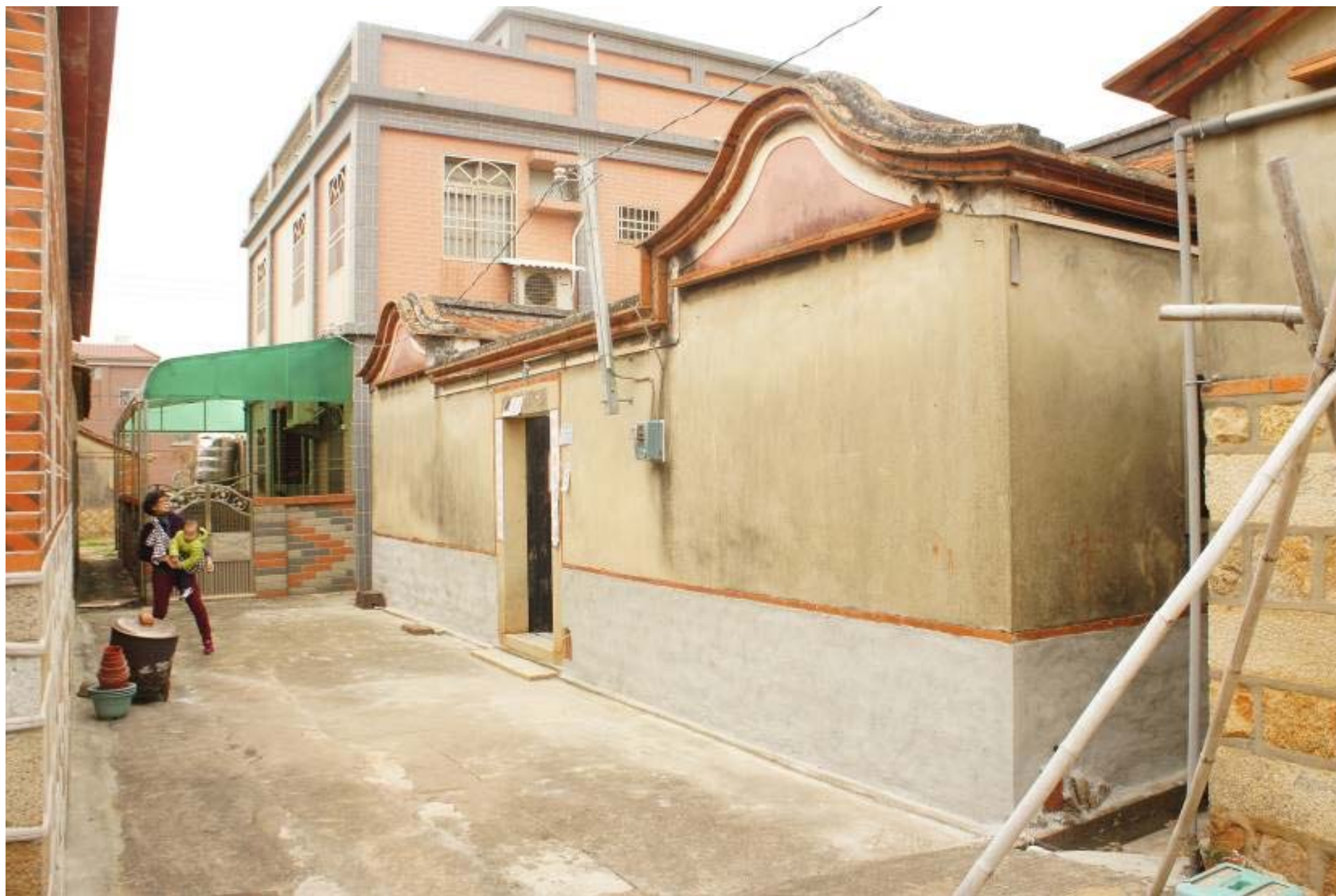
后浦頭60號-立面修復前
