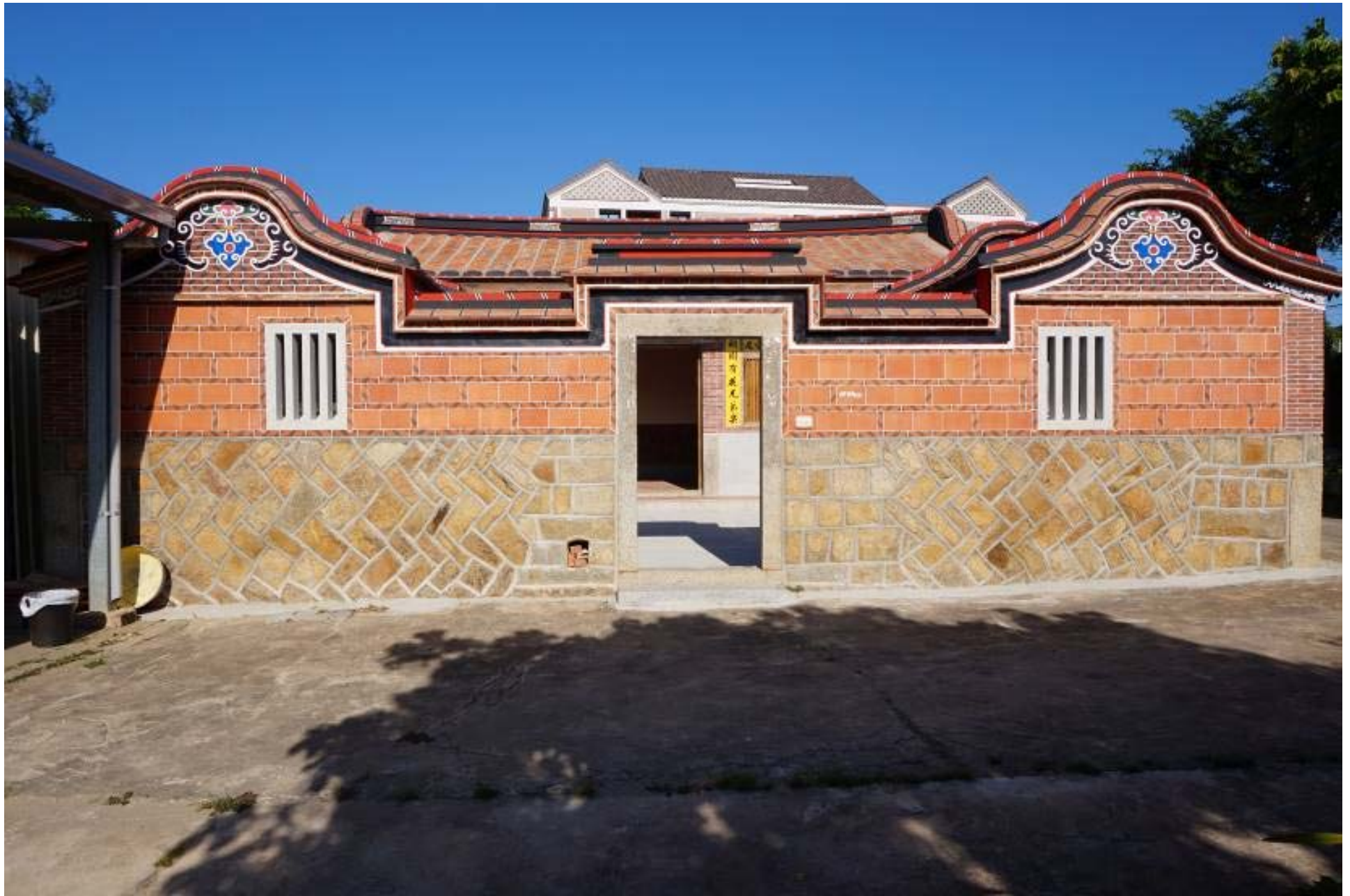
中蘭29號-立面修復後
