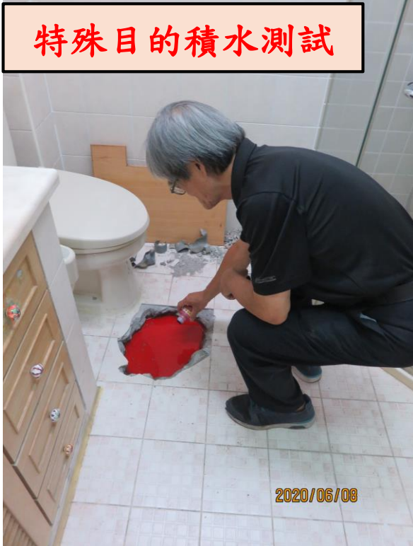
浴室放水積水測試
