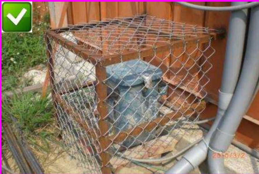
臨時電配電盤及變壓器圍設防護
