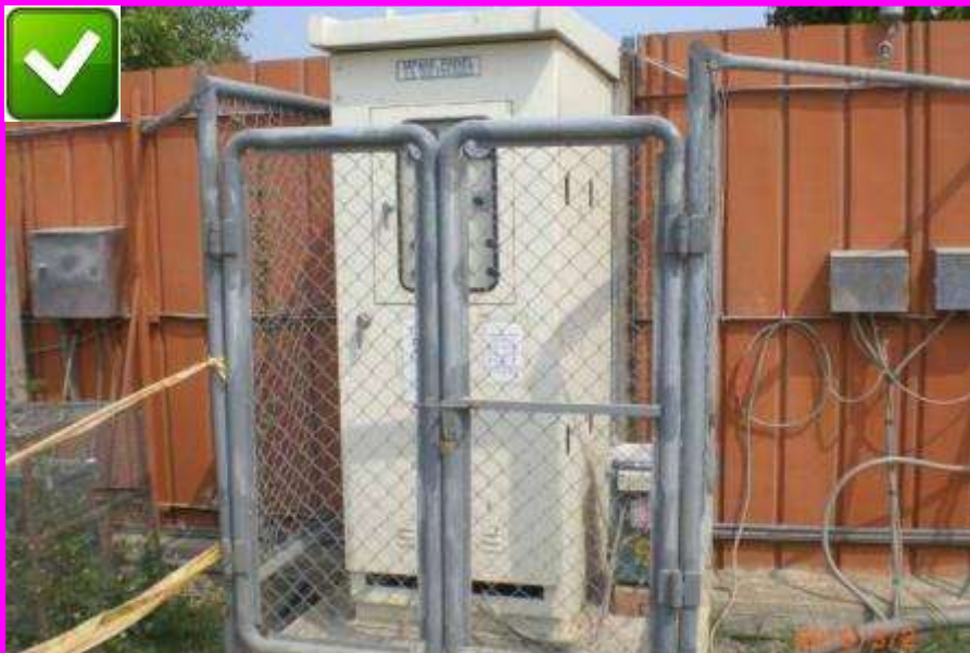
臨時電配電盤及變壓器圍設防護
