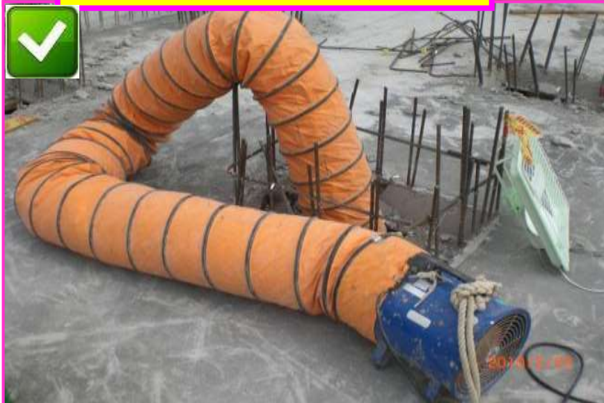
設置鼓風機送風及風扇抽風，持續送風
