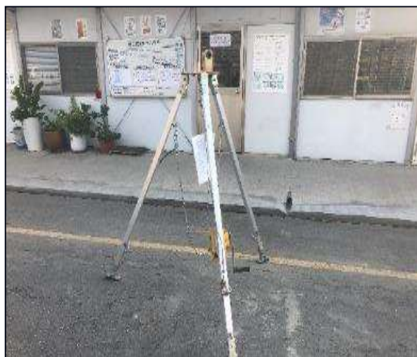
局限空間救援設備
