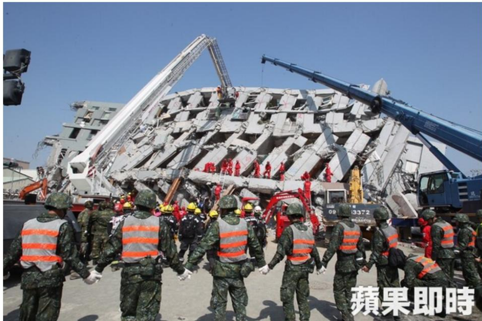
維冠金龍大樓救災現場。資料照片
