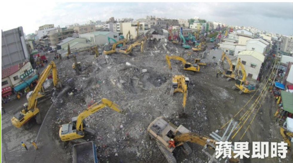
「維冠金龍」大樓倒塌後，救災人員持續在現場搜救，拆除建物。資料照片
