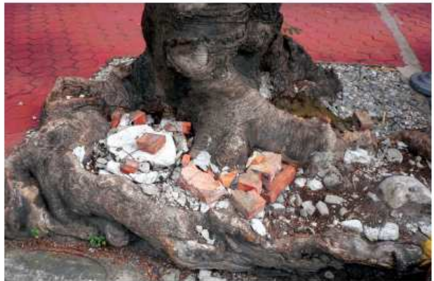
樹穴過小引起的盤根現象。
