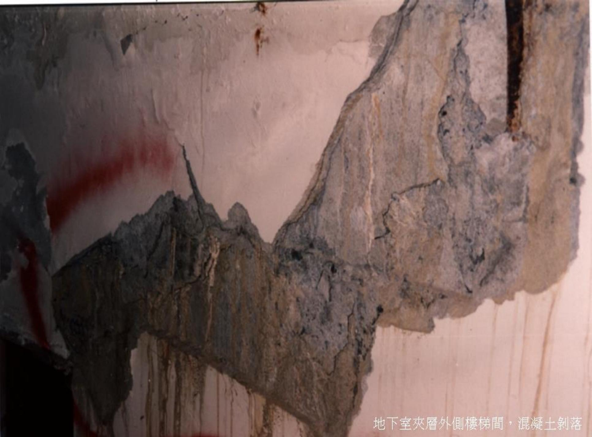
地下室夾層外側樓梯間，混凝土剝落
