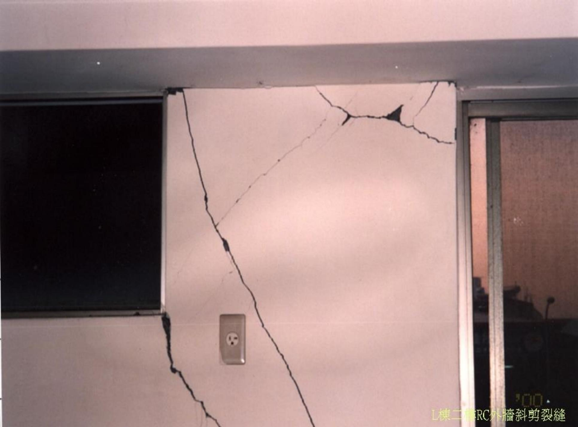
L棟二樓RC外牆斜剪裂縫
