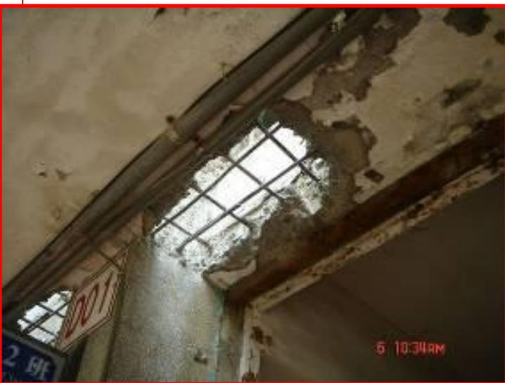
可採單側鋼筋直通，單側鋼筋植筋之設計方式，以減少植筋失敗的機率。
