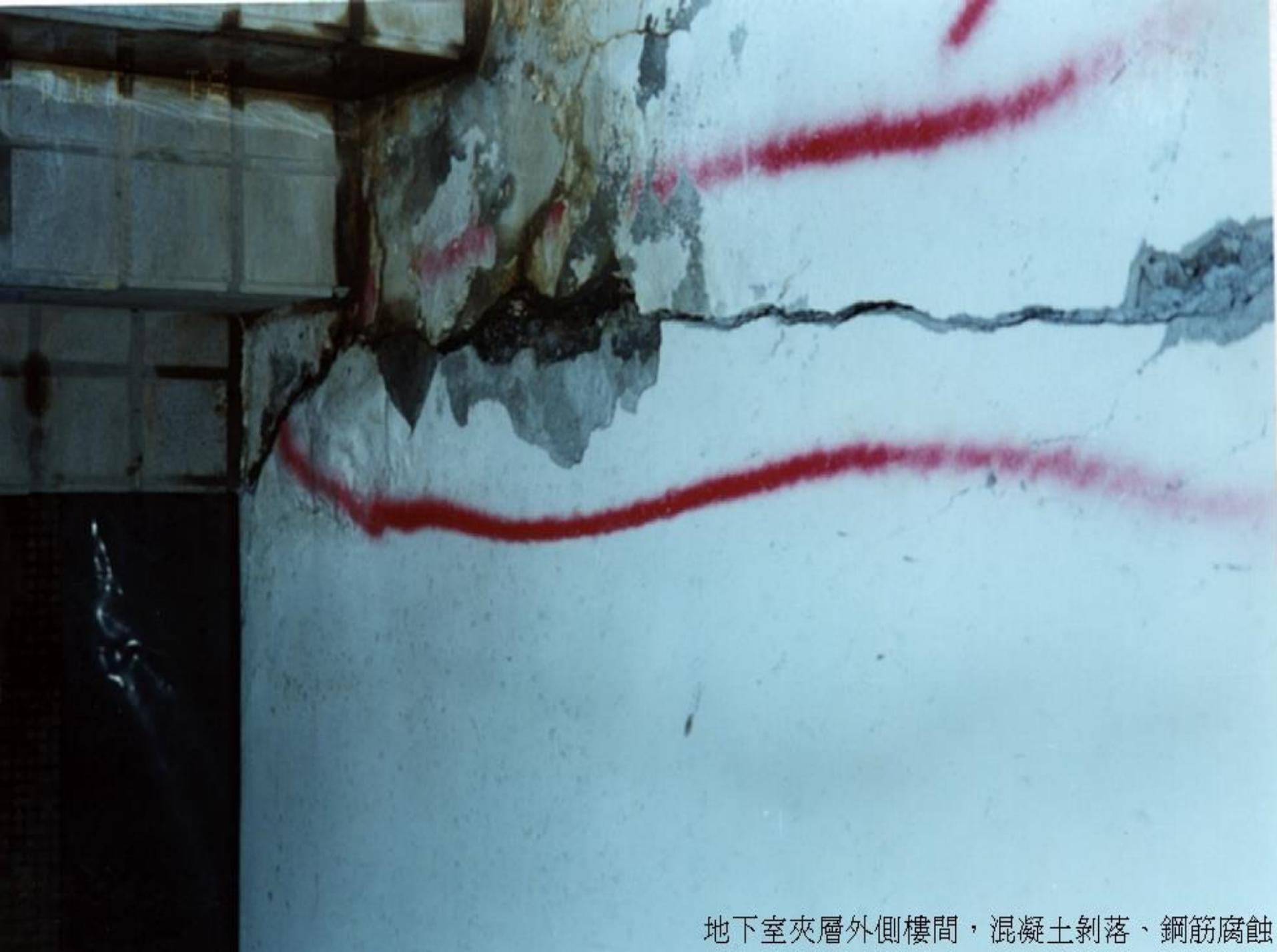
地下室夾層外側樓間，混凝土剝落、鋼筋腐蝕
