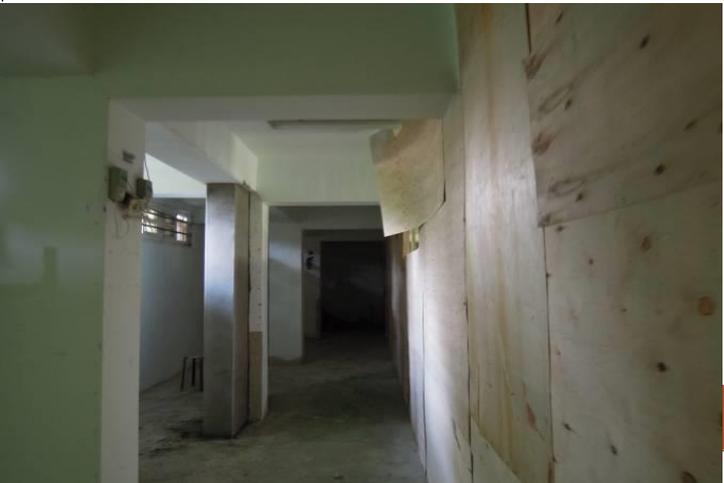
翼牆補強應向下連續至基礎，地下室內柱翼牆底部採植筋於地梁方式施做
