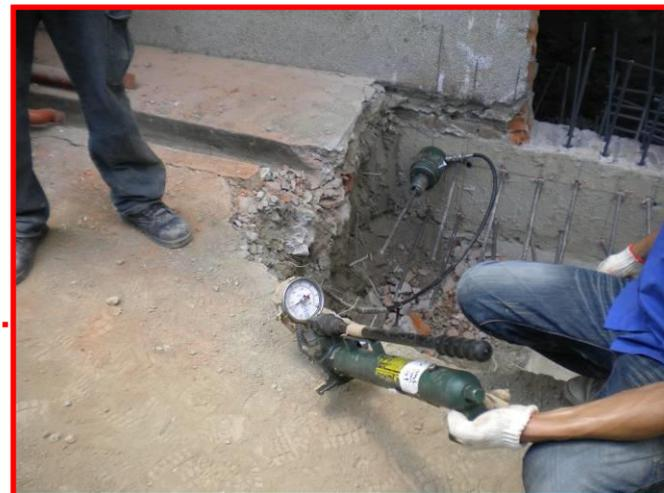
單側鋼筋直通方式，不需採喇叭口灌漿
