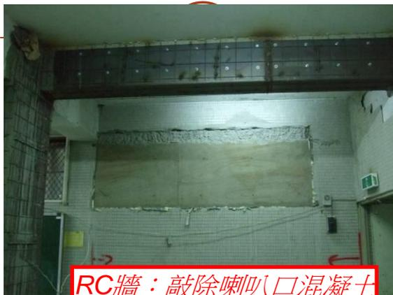
RC牆：敲除喇叭口混凝土
