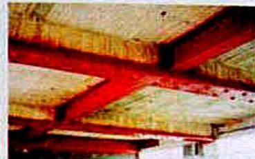
RC梁強度不足時可以鋼板來補強
