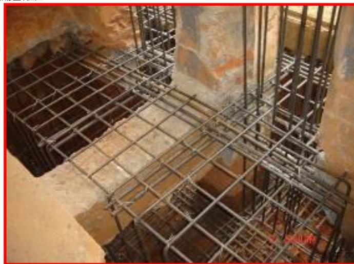
基礎鋼筋遇原有柱無法直通(斷筋)
