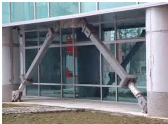
銀泰中心設置粘滯阻尼器內筒及平面布置圖(部分樓層)
