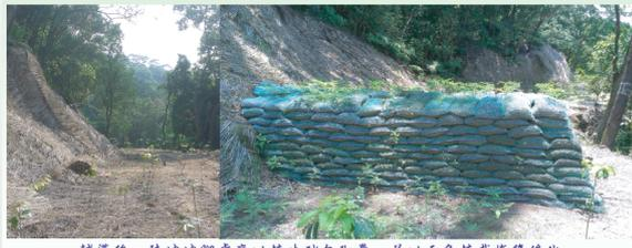
輔導後，陡坡坡腳處應以植生砂包砌壘，並以三角植栽恢復綠化。
