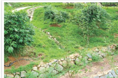
輔導後 - 砌石溝導水，設置平台階段及砌石駁坎
