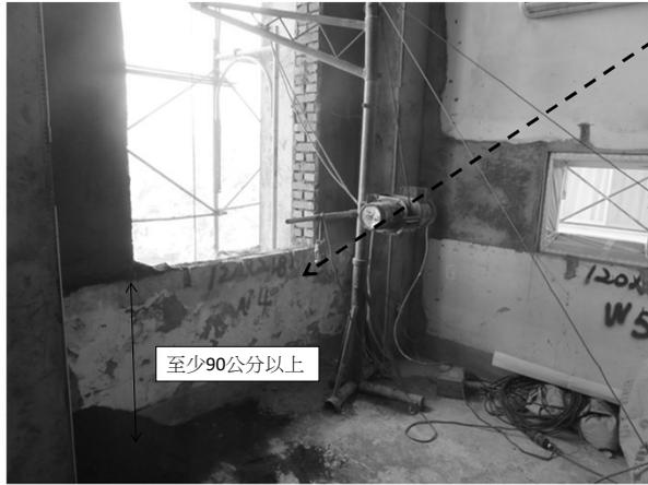
利用窗台高度當作護欄進行吊料作業
