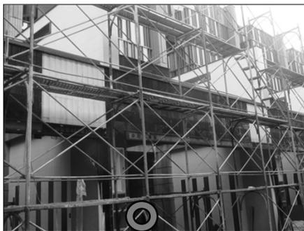
**施工架內、外側應設置交叉拉桿**，高度2公尺以上之施工架內、外側應增設下拉桿及**施工架兩端立架及轉角處應設護欄**，上下設備之交叉拉桿上方應設置適當護欄
