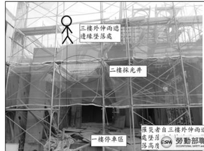
於高度6.8公尺之A1棟3樓進行梁底及板底模板面清掃作業時，因3樓外伸雨遮模板邊緣開口部分未設有護欄、護蓋或安全網，且罹災者未戴安全帽，致使罹災者於3樓外伸雨遮清掃模板面時，不慎自該外伸雨遮處墜落至1樓地面
