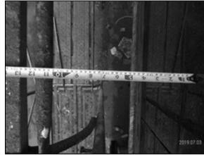
站立之高度2公尺以上外牆施工架與結構體距離為33公分，於拆除施工架內側無交叉拉桿及下拉桿後，未設置防墜網或輔助板料等設施。
