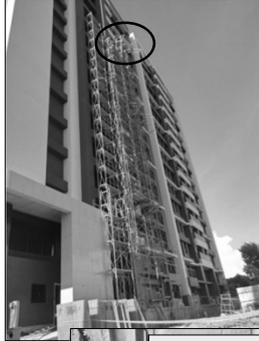
1.高度7公尺以上施工架之拆除，未事先就預期施工時之最大荷重，依結構力學原理妥為設計，置備施工圖說，並指派所僱之專任工程人員簽章確認強度計算書及施工圖說。營造安全衛生設施標準第40條第1項第1款
