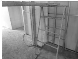
當時施作位置為一樓西南側電梯外部周邊牆壁，罹災者站在由三座鋼管合梯上面鋪設施工架踏板之平台作業，另一員則站於1樓地面上將拌好之水泥砂漿遞給罹災者進行電梯外部上方牆壁之粉刷，罹災者於工作平台上移動時，因踏板未固定，且重疊處有些許高低落差致使腳步未踩穩，往後摔落至1樓地面。
